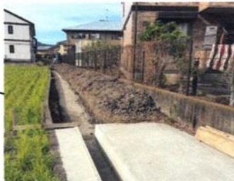
①堀の改修工事(2期工事)
