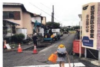
⑦公会堂前 道路陥没修復
